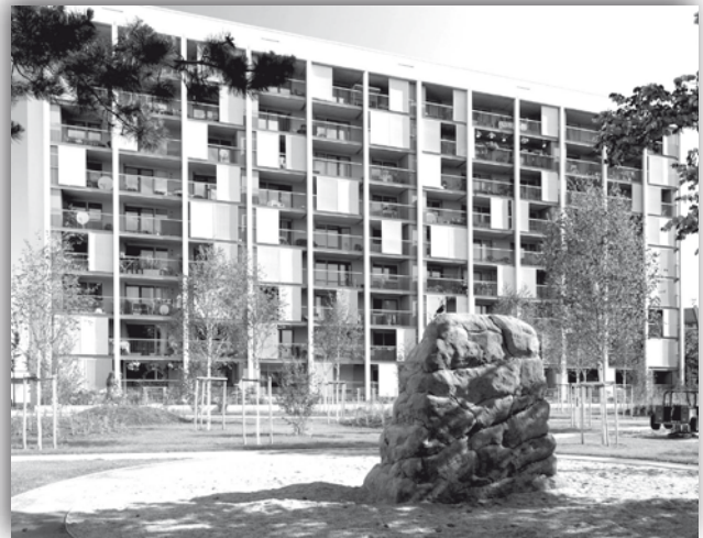
Bayerisches Modernisierungsprogramm – Energetische Modernisierung und Aufwertung einer Hochhausseife in Ingolstadt (Foto: Reinhard Feldrapp, Naila)
